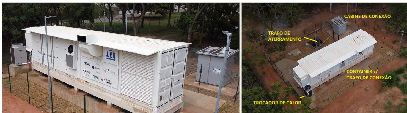
Figura 2 – SAEB #1 – 750 kVA / 1000 kWh / Baterias de Lítio
