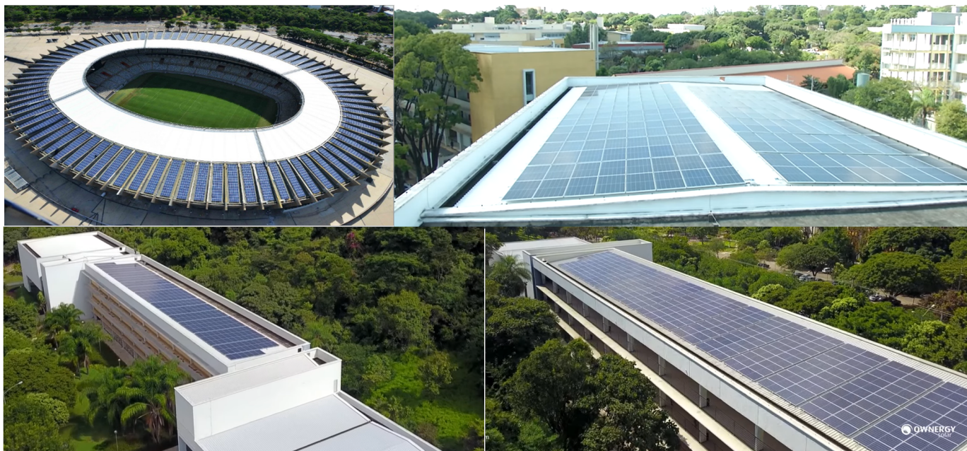
Figura 4 – UFVs – Mineirão (1400 kWp) / CAD 1 (130 kWp) / CAD 2 (230 kWp) / CAD 3 (150 kWp)
