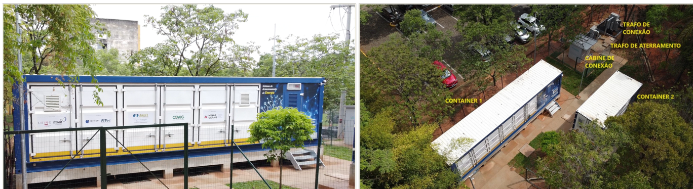
Figura 3 – SAEB #2 – 500 kVA / 750 kWh / Baterias de PbC
